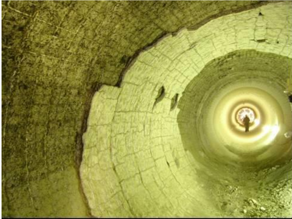
Foto 1. Zona del horno con ladrillos descabezados
