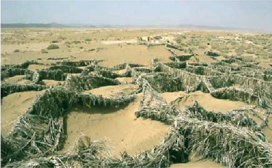
**FIGURA 10.58** Empalizadas dispuestas en zigzag para atrapar la arena transportada por vientos de direcciones variables. Foto J. L. Peña.
