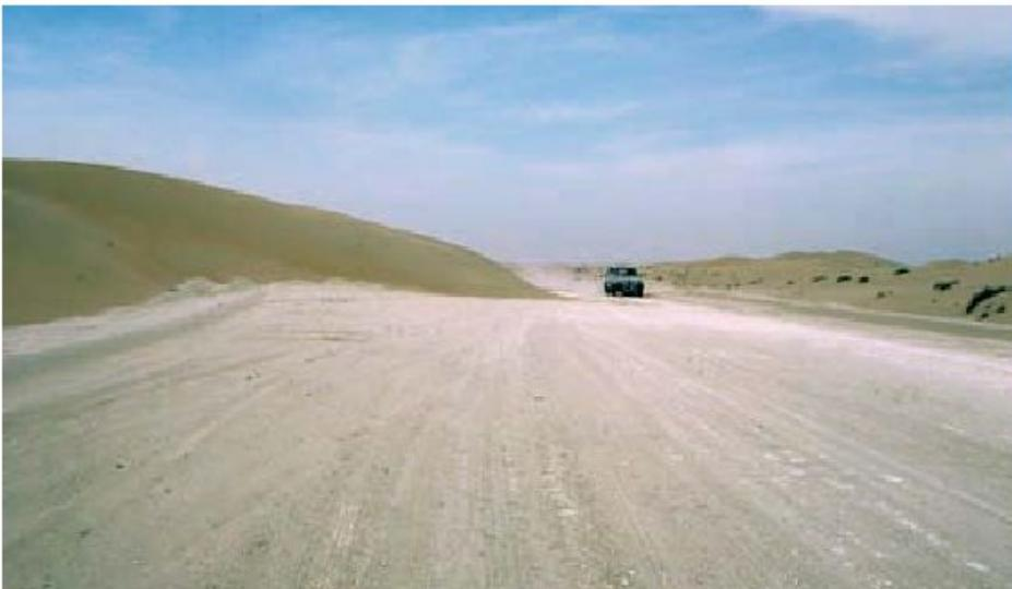
**FIGURA 10.54** Dunas avanzando hacia una carretera. Maharaga, Sur del Desierto de Rub al Khali (Unión de Emiratos Árabes).
