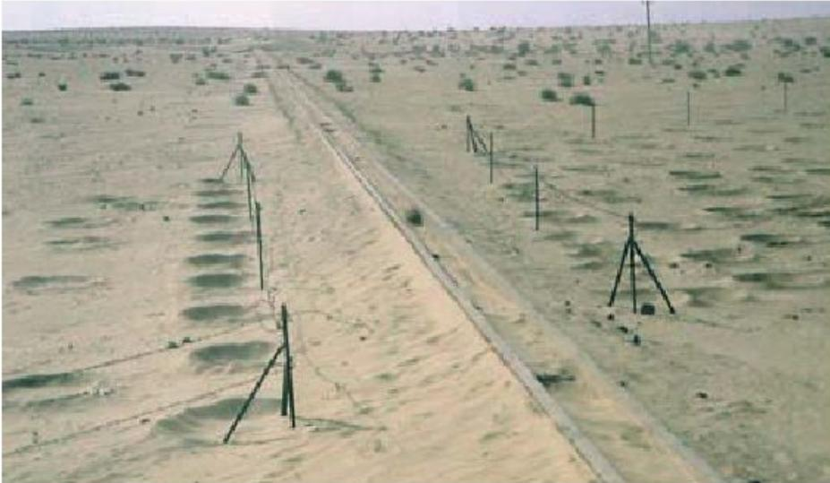
**FIGURA 10.53** Acequia parcialmente enterrada por arena. Corresponde al plan de puesta en regadío de parte del Desierto del Thar, a partir del Gran Canal de Indira Gandhi. Jaisalmer (provincia de Rajastan, India).
