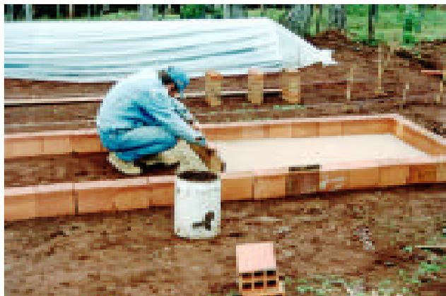
FOTO N°3: construcción de pileta con ladrillos y cobertura de base con arena
