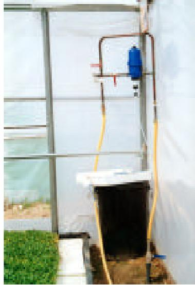
FOTO N° 21: Inyector-dosificador para agregado de fertilizantes en invernaderos comerciales
