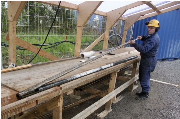
Operación de extracción de testigo (Atlas Copco)
