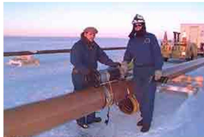
Radiografía de soldaduras
