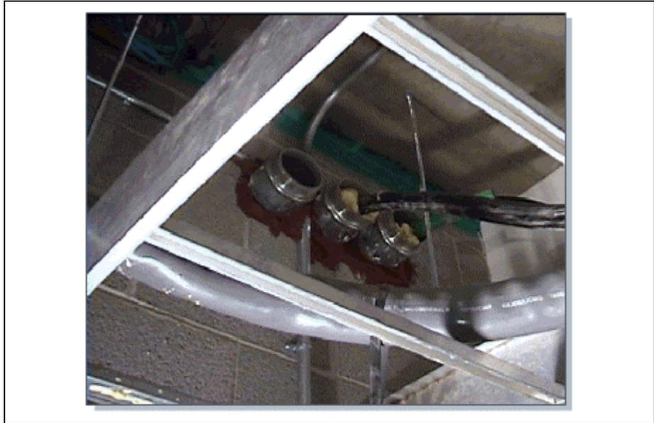
**Figura 1 Penetración típica de un muro cortafuegos**
