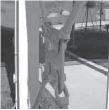
Arriostamiento diagonal para un pasillo elevado; se muestra una horquilla y un pasador sometidos a cortante doble
