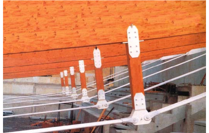
Viga de madera aserrada armada con sist. de atirantado Detan
