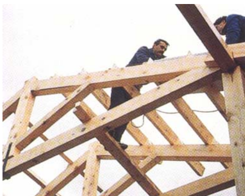
Fig. 18. Estructura de cubierta de madera aserrada
