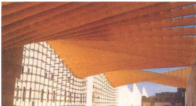
Fig. 181. Estructura de madera laminada de la cubierta alabeada en fase de montaje.
