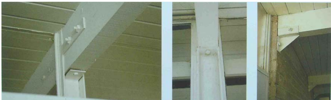
Fig. 147. Expresión de las conexiones entre metal y madera.
