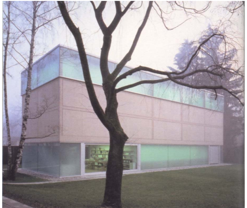
Fig. 152. Vista exterior desde el jardín: se puede apreciar el simple container simétrico con una piel cambiante pero de materiales relacionados (vidrio esmerilado, madera de abedul y aluminio arenado).
