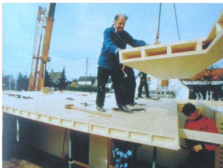
Fig. 45. Utilización de los mismos elementos para resolver tanto muros como entresijos
