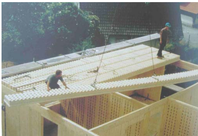
Fig. 41. Piezas nervadas dentro del grupo sistemas superficiales. Armado de un entrepiso utilizando sistema Lignotrend.
