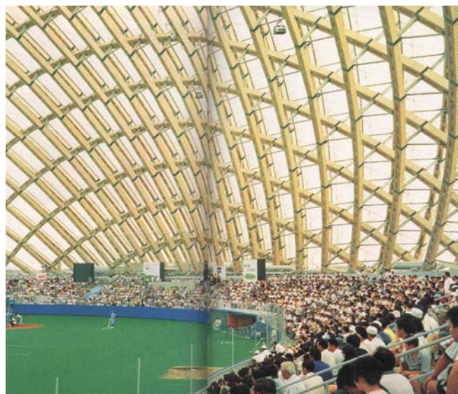
Fig. 187. Vista interior. Liviano y translúcido, el domo está realizado de madera laminada con una cobertura de teflón combinados a través del uso de una avanzada tecnología.
