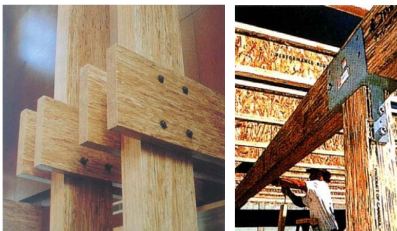
Fig. 34. Vigas y pilares de PSL; a la izquierda unión abulonada; a la derecha, en primer plano, unión mediante pieza de acero galvanizado de gran resistencia (en segundo plano vigas doble T).
