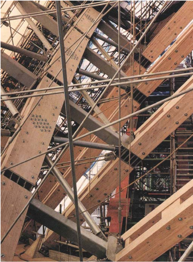
Fig. 189. La envolvente del gran espacio interior está realizada con una compleja estructura de madera de cedro laminada y acero.
