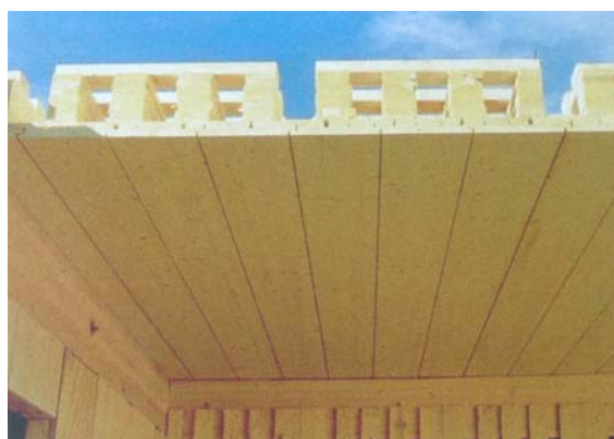
Fig. 43. Sistema Lignotrend para cubiertas, relleno con material aislante y canalización eléctrica
