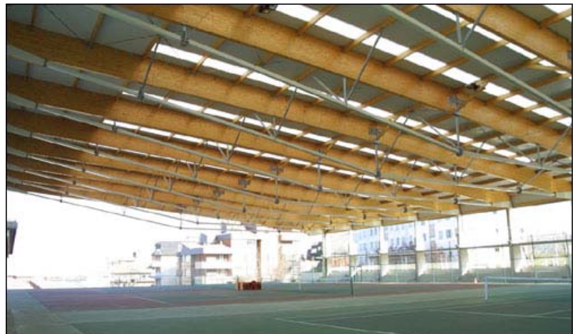
Canchas de tenis cerradas. Vigas atensoradas. Luz libre: 40 metros
