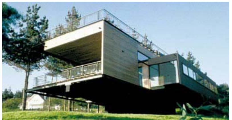
Fig. 166. Vista exterior donde se puede apreciar el gran volumen en ménsula
