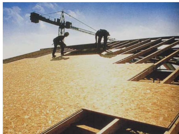
Fig. 26. Tablero de virutas orientadas (OSB). A la derecha: uso estructural de los tableros como alternativa al contrachapado.
