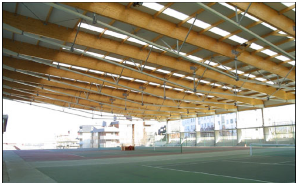
Fig. 194. Canchas de tenis cerradas. Vigas atensoradas. Luz libre: 40 metros
