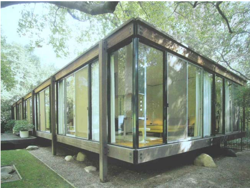
Fig. 151. El edificio es un paralelepípedo elevado del terreno por medio de pilares de madera de secuoya. Todas las esquinas se dejaron libres de apoyos.
