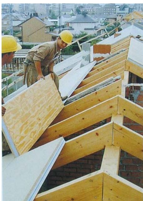
Fig. 31. Colocación de paneles sándwich.
