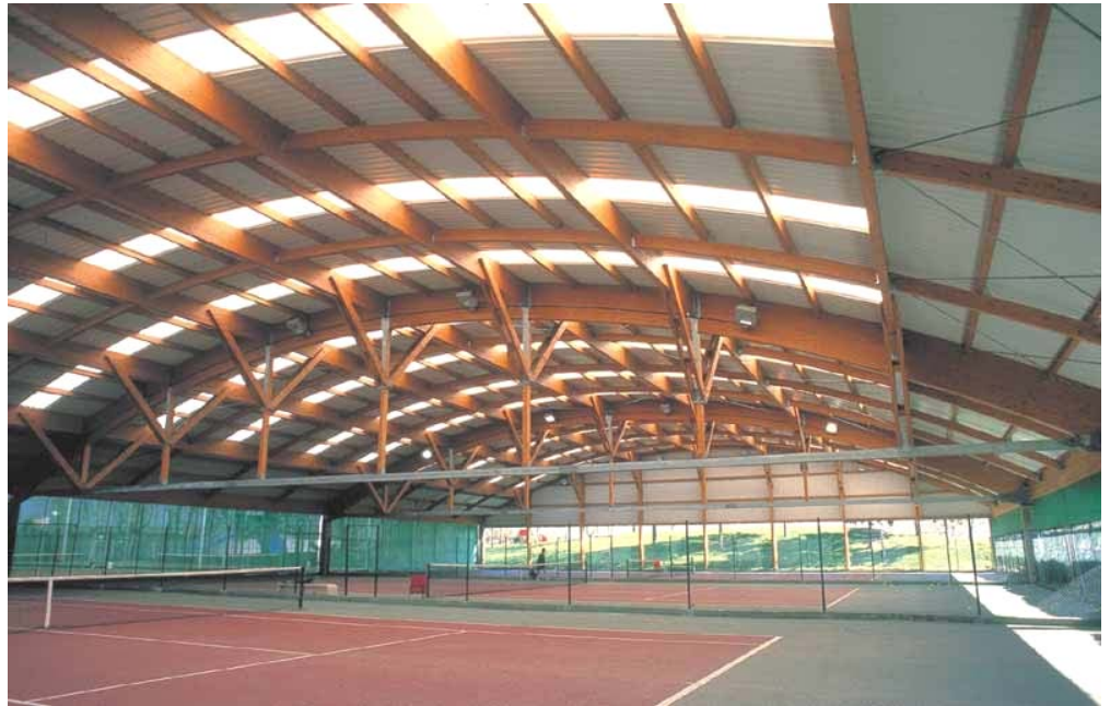
Fig. 193. Canchas de tenis cerradas en Oporto, Portugal. Arcos biarticulados atirantados. Luz libre: 40 metros.
