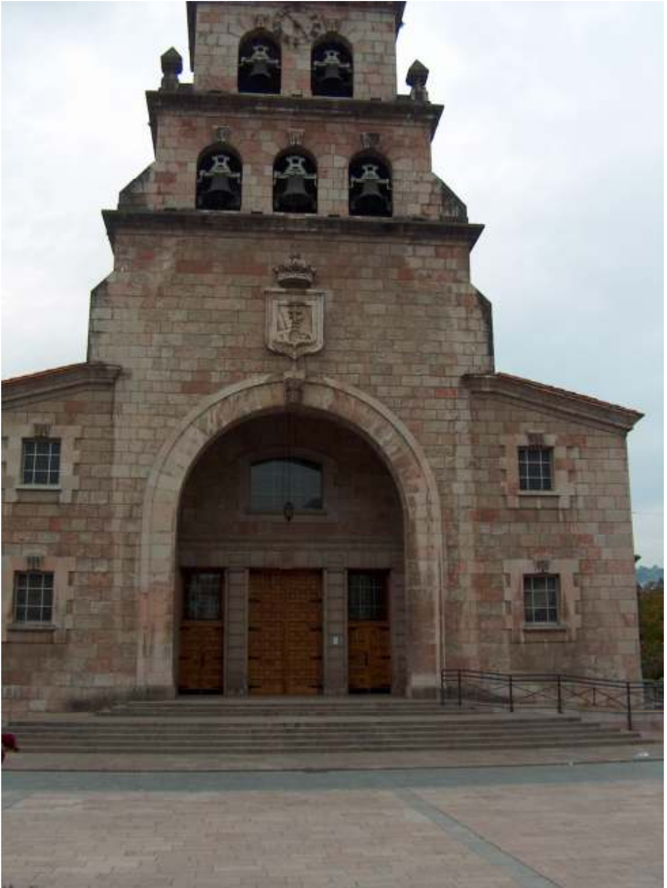
Figura 6.3.4.2.5.- Obra realizada con sillares
