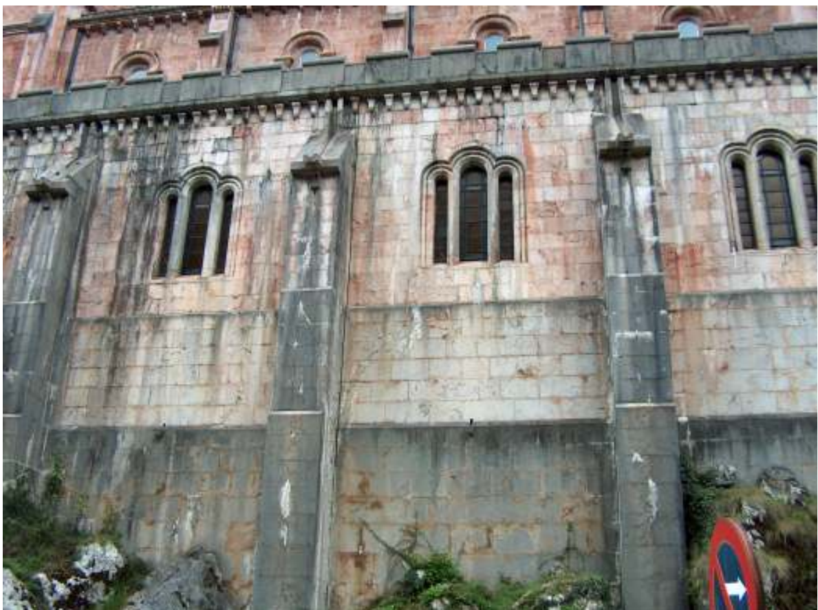
Figura 6.3.4.2.5.- Obra realizada con sillares
