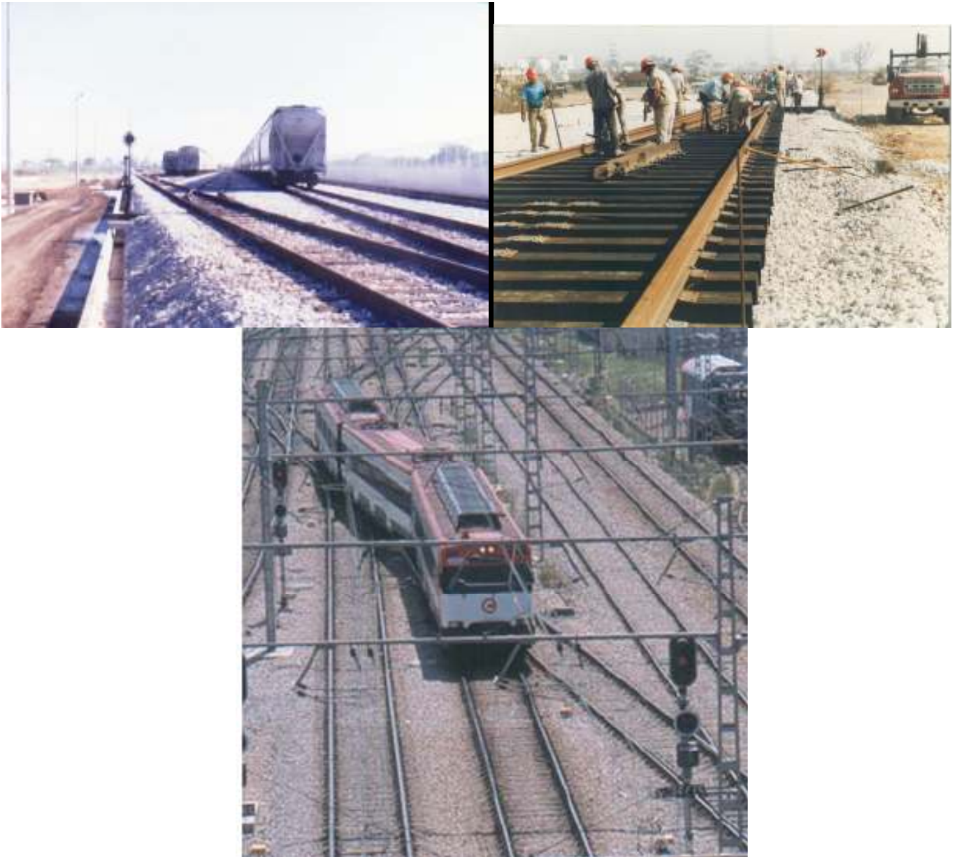
Figura 5.1.1.c.- Construcción de vías férreas.
