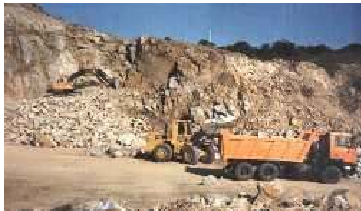
Maquinaria trabajando en Cantera
