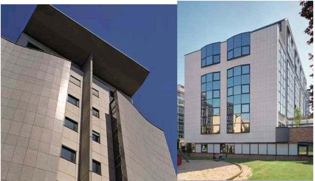
Figura 6.3.4.5.3.-Aplacados de piedra natural.
