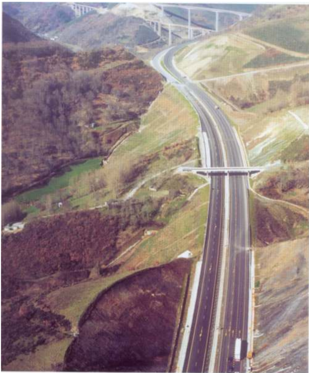
Figura 5.1.1.b.- Firmes de carreteras
