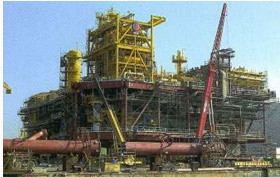
Instalaciones en montaje – Control inicial
